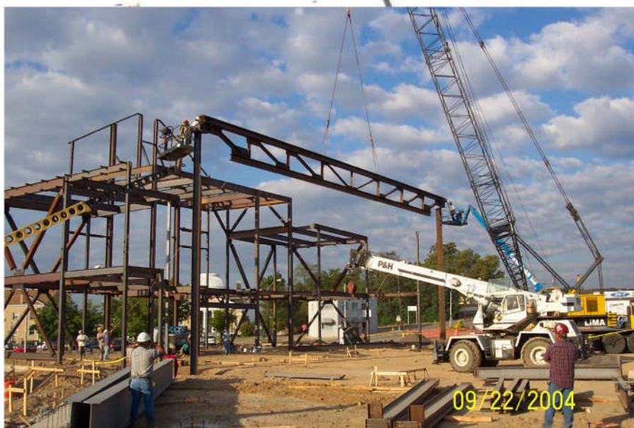
Primena radnih platformi na montaži čelične konstrukcije
