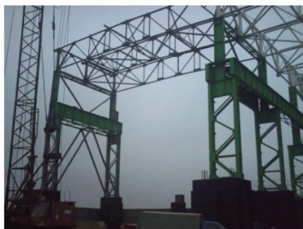
Montaža čelične konstrukcije krova valjaonice limova u gradu Viksa (Rusija), počev od sprežnog polja
