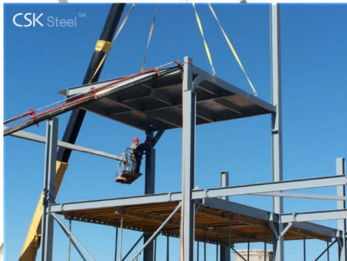
Primer montaže u blokovima – montaža dela međuspratne konstrukcije
