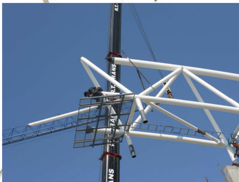
Primer radne (zaštitne) platforme pričvršćene za deo konstrukcije
