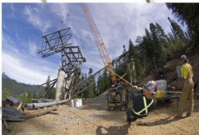
Usmeravanje montažnog komada uz pomoc uzadi
