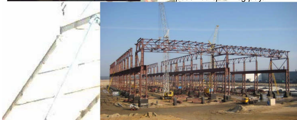
Montaža čelične konstrukcije krova valjaonice limova u gradu Viksa (Rusija), počev od sprežnog polja
