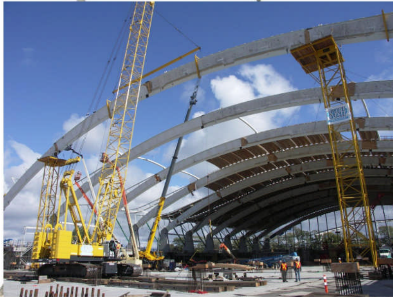
Primer primene traverze na montaži sandučastog glavnog nosača
