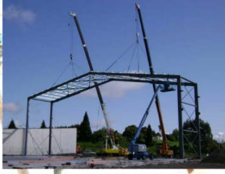
Primer montaže u blokovima
